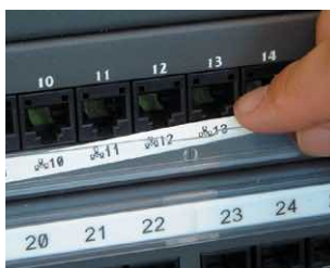
Labels voor aansluitklemmen en patchpanelen
